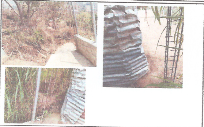
Foto 1: CERCO MURO PERIMETRAL
