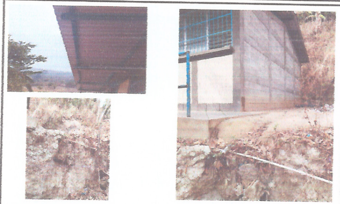
Foto 2: CANAL BAJADA DE AGUA PLUVIALES
